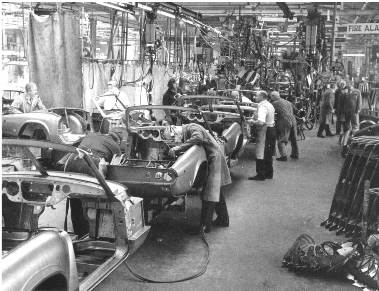
Il montaggio del cofano di una Spitfire era un'operazione completamente manuale e che richiedeva attenzione e precisione.
